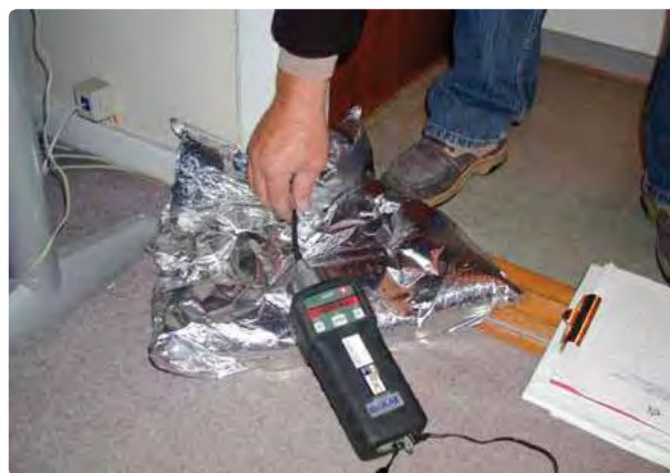
Foto: I lägenheter ovanför kemtvättar kan perkloretylen tränga in genom sprickor i bjälklaget. Med "sniffer-metoden", som utvecklats av FORCE Technology, är det möjligt att identifiera områden med kraftig inträngning.
