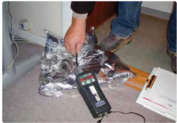
Foto: I leiligheter over renserier kan perchlorethylen trenge inn via revner og sprekker. Med "sniffemetoden", utviklet av FORCE Technology, er det mulig å peke ut områder med kraftig inntregning.
