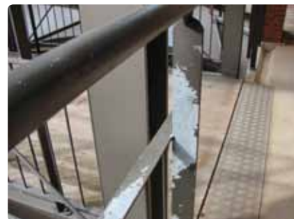
Et år gammelt Duplex-system malet med alkydmaling er ødelagt. Omkostning til reovering anslået > 50.000 kr.
