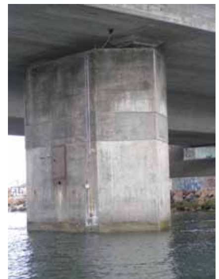
Figur 5: Nærbillede af installation af CorroRisk-sensorer
