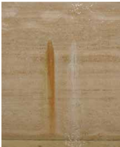
Hvide og brune udfældninger på et helt nyt springvand
