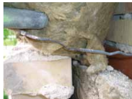
Boligforening Fjordblink. Næsten gennemtæret galvaniseret binder ses. Foto venligst udlånt af Grontmij A/S i Aalborg
